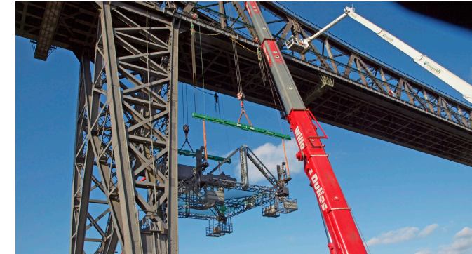
Vorbereitungen unter der Brücke, Montage Fahrwagen
