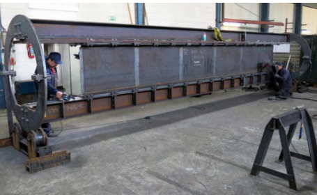
Unterbau Schwebefährenschiene: Neubau von 36 Schienenträgern und 38 Konsolen
