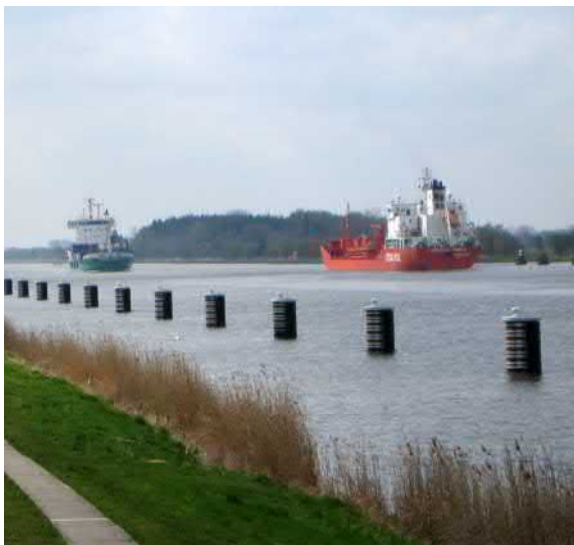
Dalbenreihe mit den neuen Stahldalben
