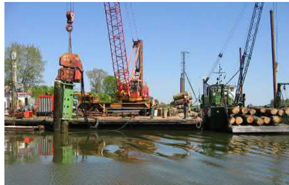
Holzdalben - Ziehen eines Rammfahls mit Rüttlerunterstützung
