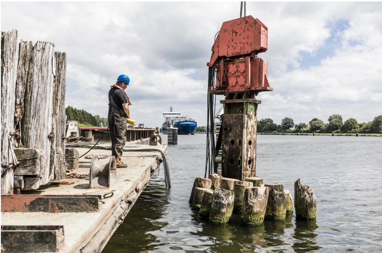
**Bildunterschrift Bild 1:** Nach dem Abtrennen des obersten Teils (links im Bild) lässt die Kanalverwaltung die Holzpfähle der alten Dalbenbündel einzeln ziehen. Im Hintergrund einer der neuen Stahldalben.
