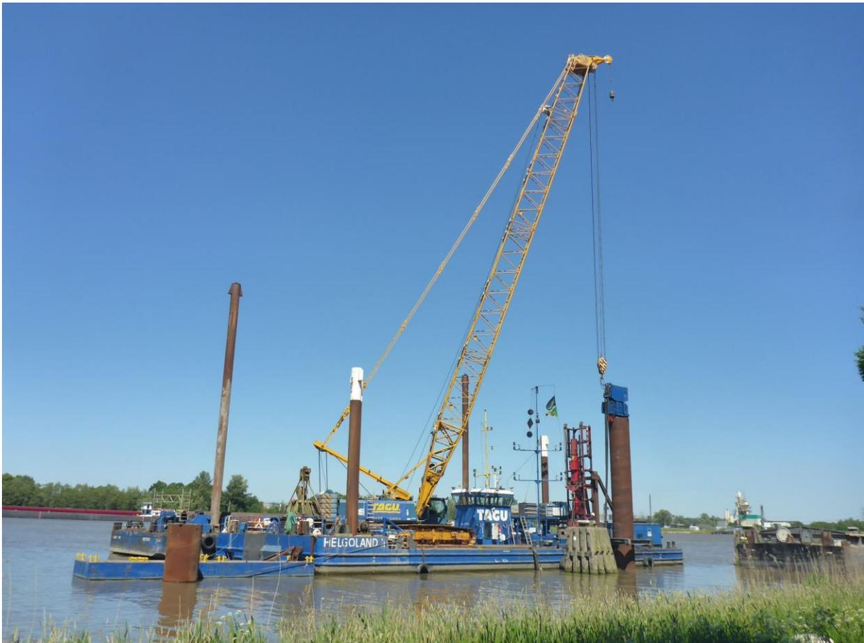
**Bildunterschrift Bild 2:** Mit schwimmendem Gerät wird am NOK ein neuer Stahlmonodalben eingebracht. Daneben ist noch eines der alten Holzdalbenbündel zu sehen.
