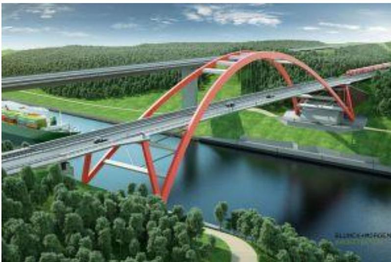
**Bildunterschrift:** Das Erscheinungsbild der geplanten neuen Levensauer Hochbrücke orientiert sich am Vorgängerbauwerk. Rechts ist das alte Widerlager Süd zu erkennen.
