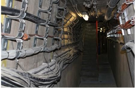
**Bildunterschrift**: Blick in den Betriebsgang zwischen den Röhren des Rendsburger Straßentunnels. Hier wird die neue Trasse der Stromverteilung verlaufen.
