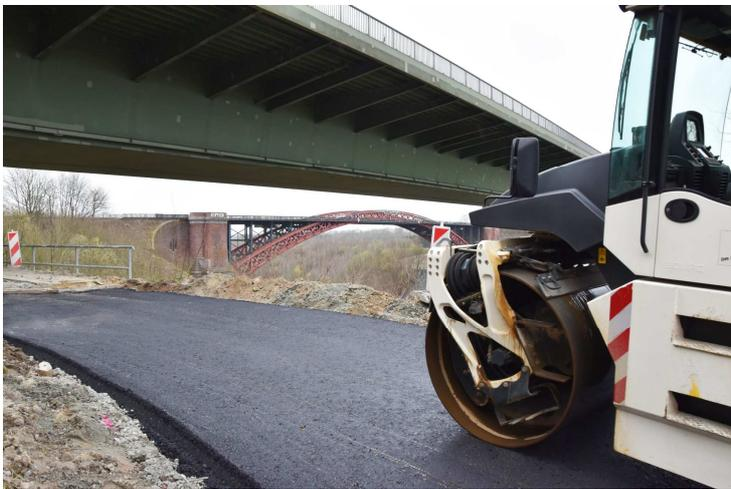
**Bildunterschrift:** An der zweiten Levensauer Hochbrücke werden Baustraßen von der B76 zum Baufeld für den Ersatzneubau der ersten Hochbrücke asphaltiert.
