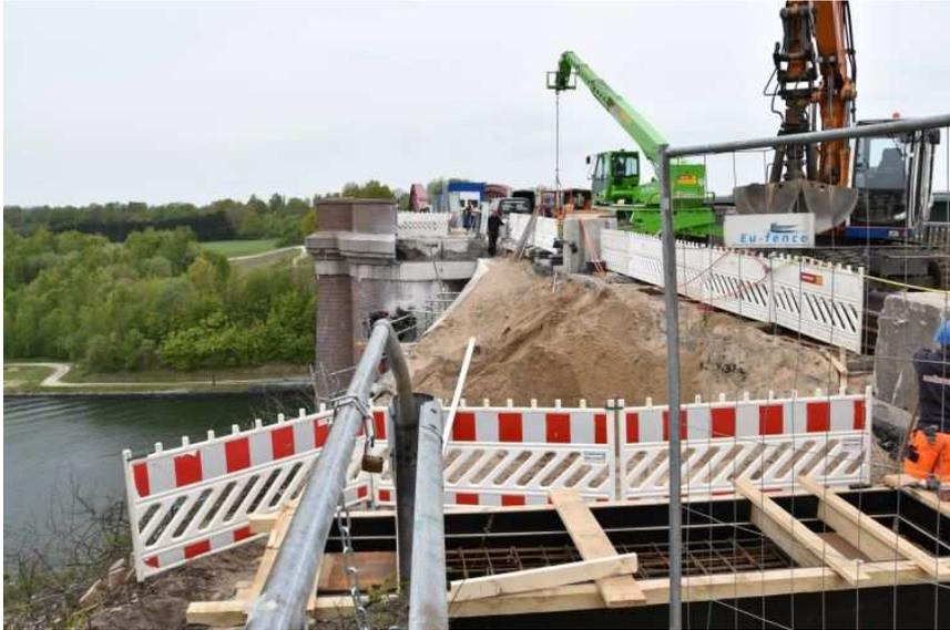
**Bildunterschrift:** Die Arbeiten oberhalb des südlichen Widerlagers der Levensauer Hochbrücke sind in vollem Gange, Teile des Fuß- und Radweges bereits zurückgebaut.
